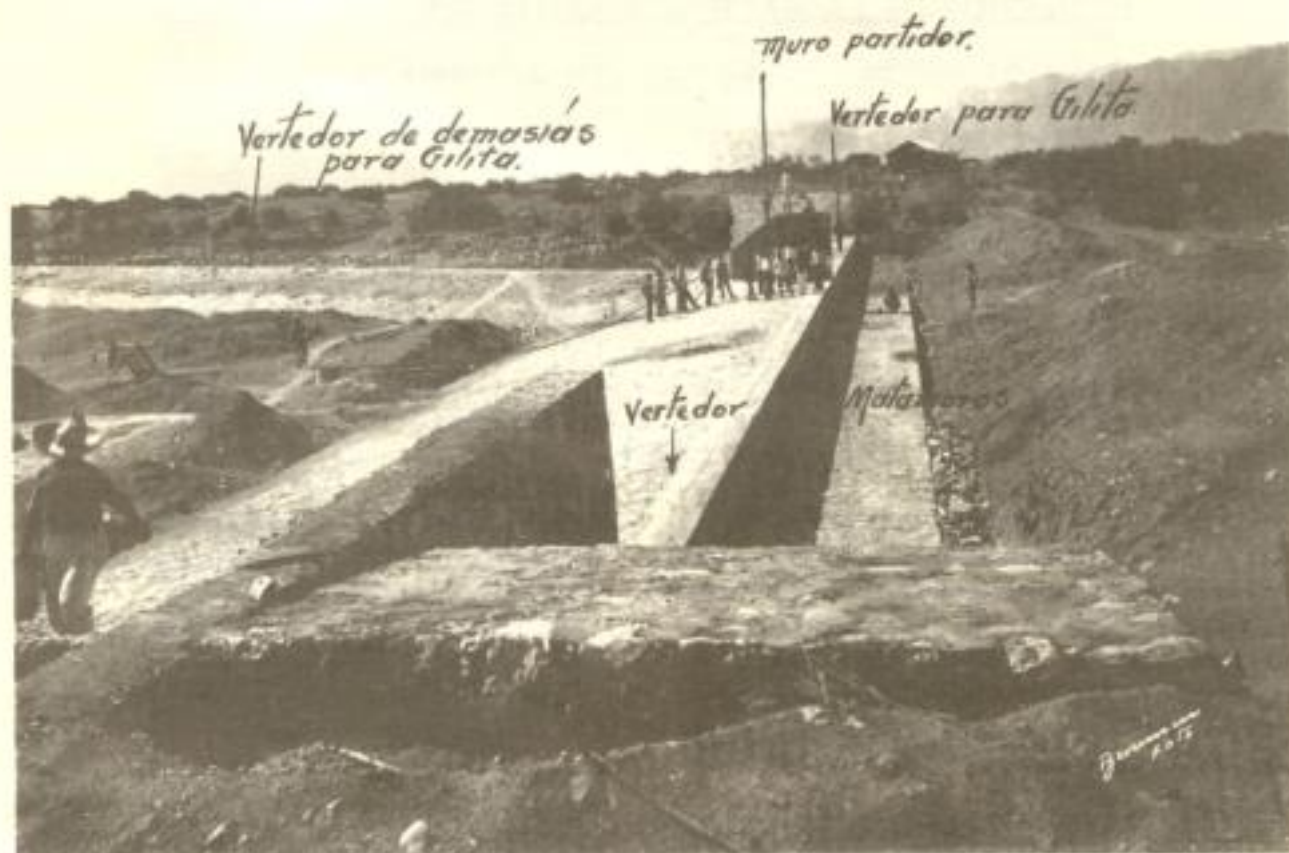
Vista general de las obras de construcción de los vertedores para Gilita y Matamoros, Coahuila (1927), AHA, Aprovechamientos Superficiales, caja 1175, exp. 16429, f. 68-69.
