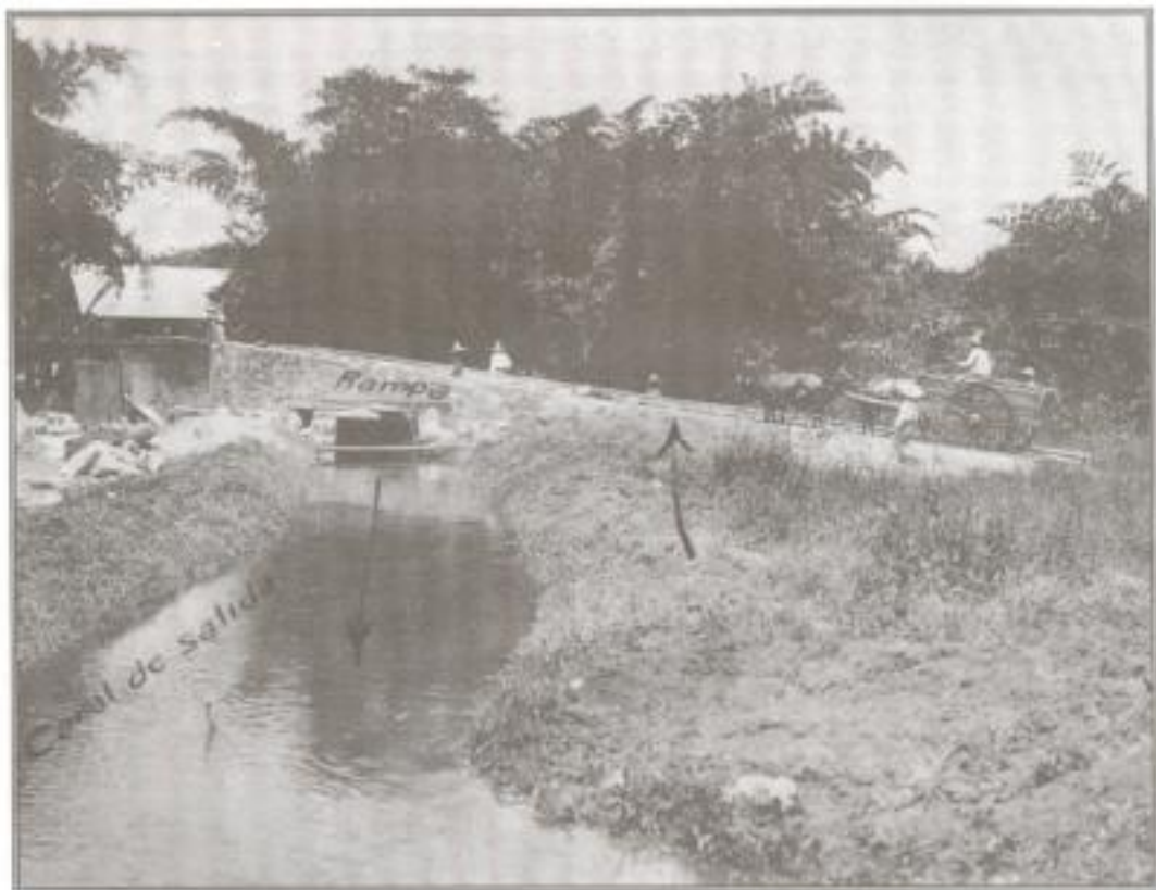
Vista parcial de rampas construidas en las riberas del rio Tambaque y sobre el canal general, Tancanhuitz, San Luis Potosí (1907). AHA, Aprovechamientos Superficiales, caja 4507, exp. 59690, f. 130.
