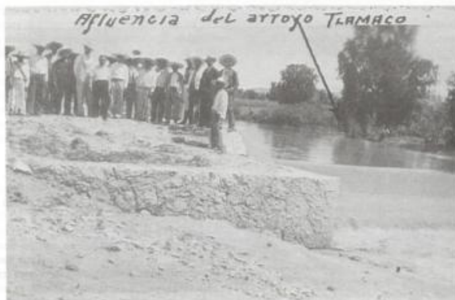
"Presa El Salitrillo en la confluencia del Arroyo Tlamaco y Río Salado, nótese el bajo nivel de la margen derecha del arroyo Tlamaco", Hidalgo (1938). ANIA, Aprovechamientos Superficiales, caja 905, exp. 12897, f. 171.
