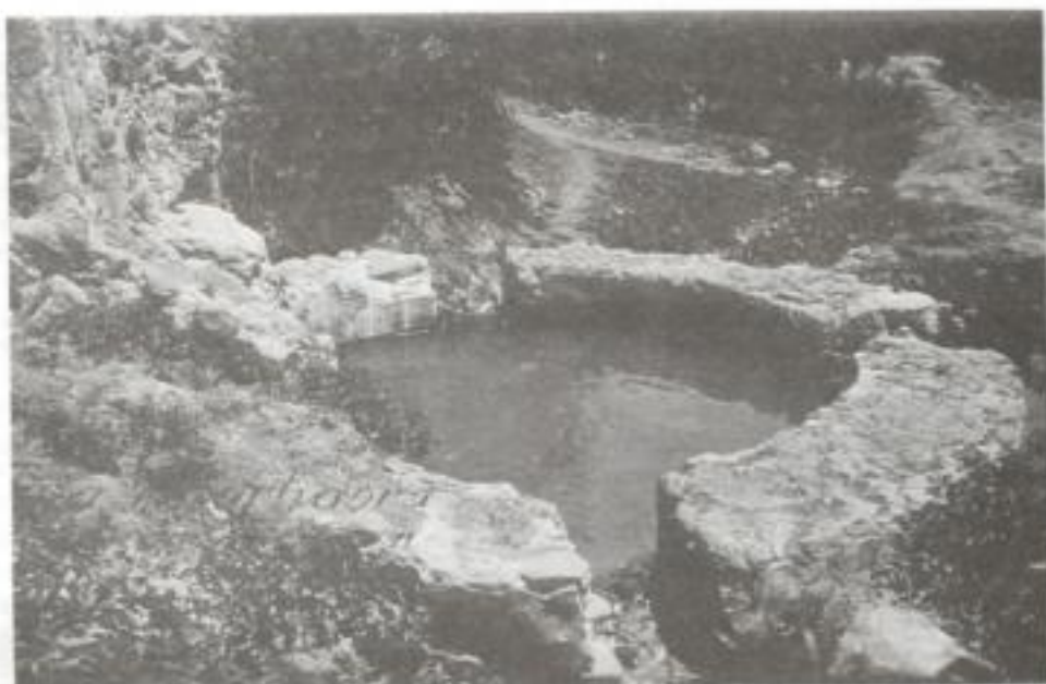
"Taza repartidora de la compuerta de Capula", Rio Tepotzotlán, Estado de México (1922). AHIA, Aprovechamientos Superficiales, caja 264, exp. 6345, f. 23.
