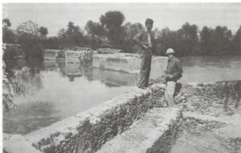
Proyecto de Salvatierra, Guanajuato, río Lerma. "Presa de Lomo de Toro. Una vista hacia el lado izquierdo a lo largo de la presa, la que controla la entrada al ramal del lado derecho" (1938).
