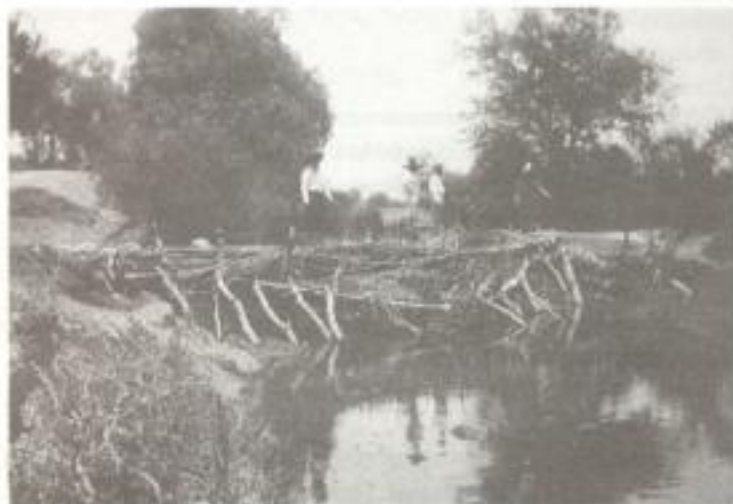
Presa provisional sobre el río salado de Tlacolula (c. 1917). AHA, Aprovechamientos Superficiales, caja 270, exp. 6508, f. 28.
