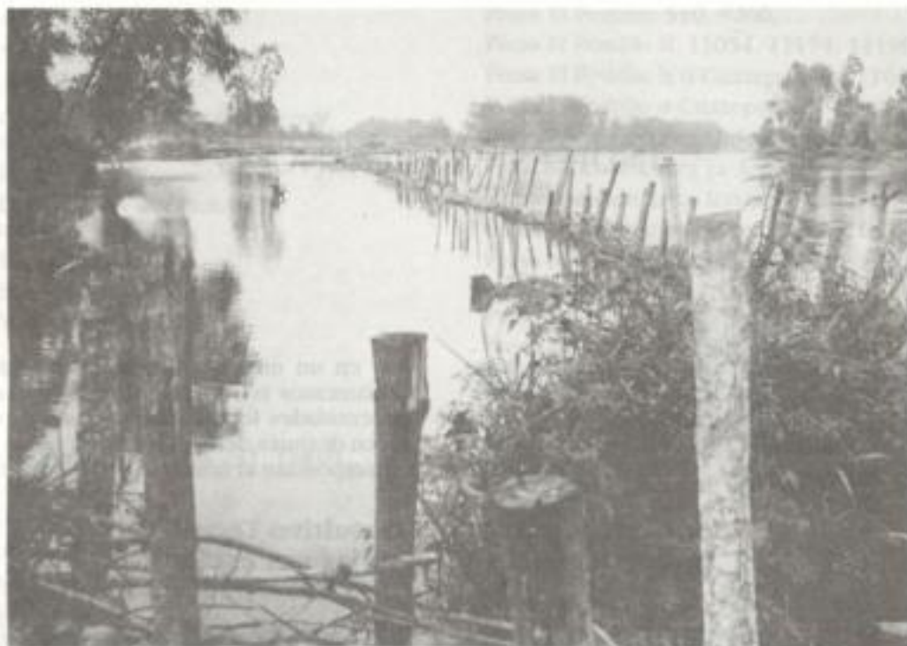
Obras de defensa en el Río Suchiate, Chiapas. Vista hacia aguas arriba a lo largo de la defensa (1947). AHA, Consultivo Técnico, caja 418, exp. 3697, f. 78.
