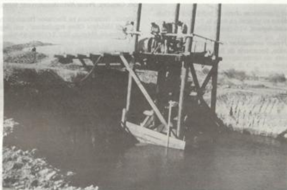
Presa Hermosillo, Sonora. Planta que sirve para bombear el agua al canal que liga con la obra de toma (1974). ANA, Consultivo Técnico, caja 418, exp. 3697, f. 149.
