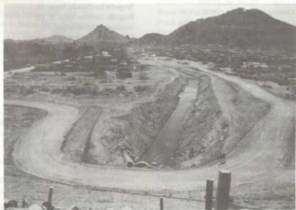
Presa Hermosillo, Sonora. Vista aguas abajo del canal de la obra de toma (1947). AHA, Consultivo Técnico, caja 418, exp. 3697, f. 147.
