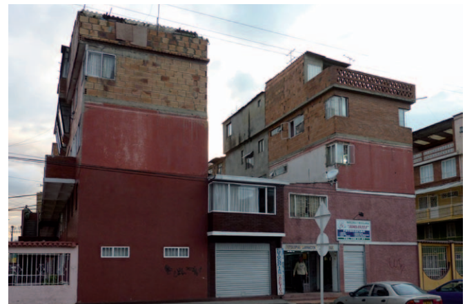
Fotografía 8. Situación actual desde las áreas públicas del proyecto, veinticuatro años después (Bachué 2010)
