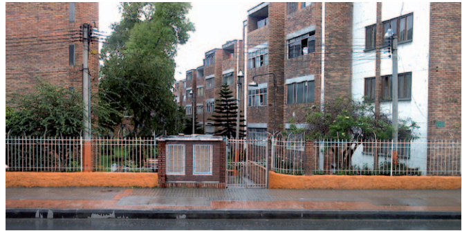
Fotografía 3. Situación actual de los cerramientos para garantizar la seguridad de los habitantes del conjunto
