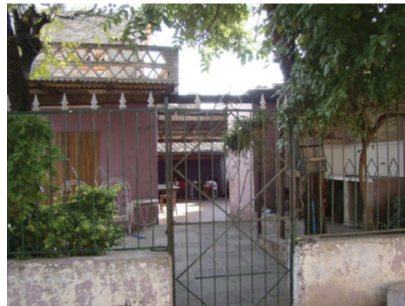
Vista de otra vivienda con la misma tipología
