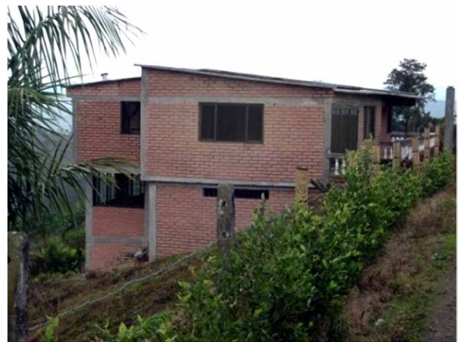
Ilustración 11. Vivienda actual en la zona de estudio. Fuente: propia. Vivienda en la finca La Aurora.
