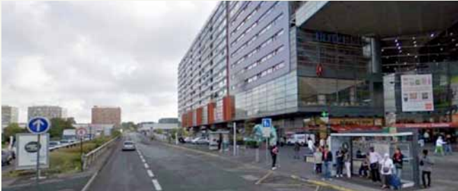
c. Euralille. Condición de "riveranidad" sobre el viaducto Le Corbusier. Fuente: archivo autores, 2009.
