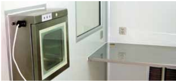
Figura 2. Vista del interior de una de las áreas. Se observa una ventana de transferencia de sellado hermético equipada con luz ultravioleta. La vestimenta de laboratorio incluye trajes de contención, respiradores de alta eficiencia, guantes de nitrilo (caucho sintético altamente resistente a solventes y a otros productos químicos) y gafas protectoras. (Figura 3)
