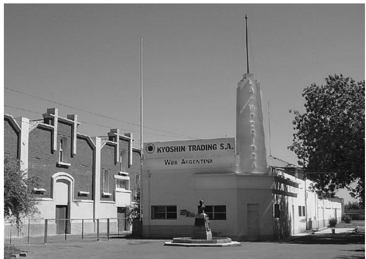
Figura 3: Bodega La Superiora en Russel (Maipú). Vista de cuerpos industriales, calle, busto del fundador y edificio de administración con mástil, 2007.
