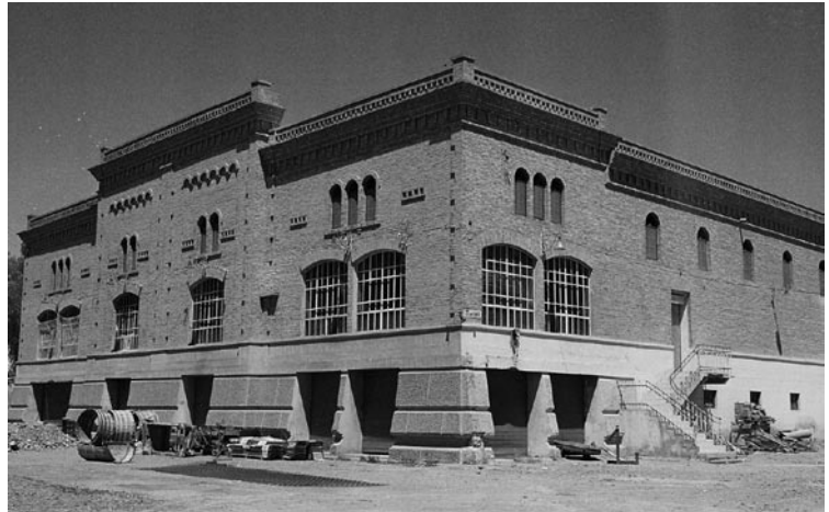
Figura 12: Bodega Trapiche, antigua Bodega Cavagnaro, en Coquimbito (Maipú). Imagen de la bodega en proceso de restauración, 2007.
