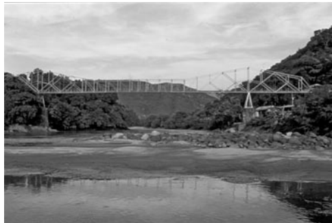
Figura 8: Puente Navarro (Honda, Tolima - Puerto Bogotá, Cundinamarca), construido entre 1894 y 1898.
