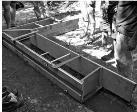
Figura 5: Tapial tradicional de madera.
