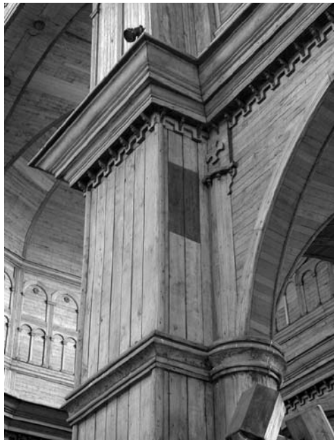
Figura 14: Las maderas lijadas; en una columna se deja una muestra (rectángulo café) del barniz de los años 50.
