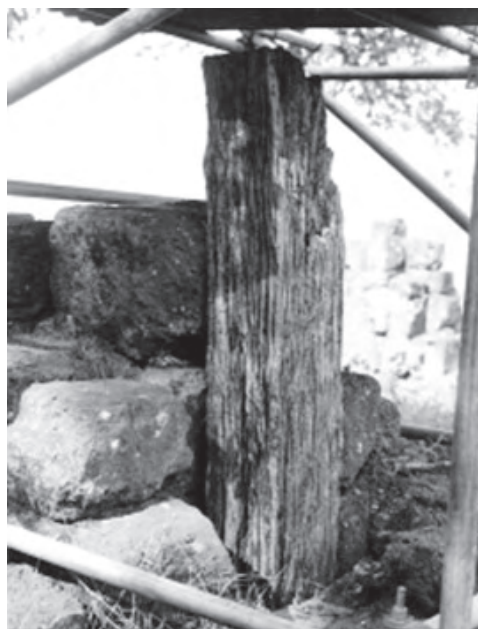
Figura 3: Pilar de madera utilizado en las estructuras autónomas, 1990.
