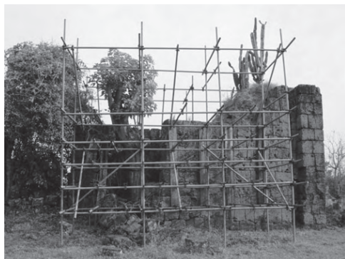
Figura 7: São João Batista, pared lateral, lado del cementerio, antes de las obras, 2003.
