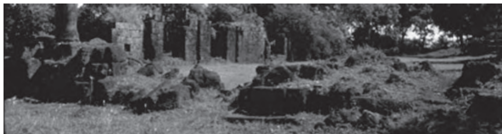
Figura 9: São João Batista, fachada principal antes de la obra, 2000.
