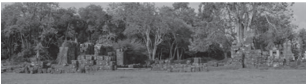
Figura 10: São João Batista, fachada principal después de la intervención, 2005.
