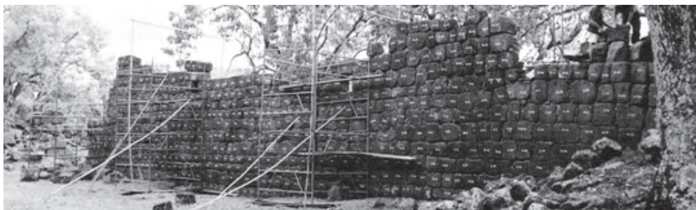
Figura 13: São Lourenço Mártir, fachada lateral lado del colegio, antes de la obra, 2005.
