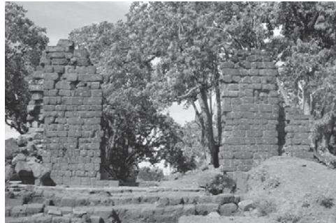
Figura 11: São Lourenço Mártir, fachada principal antes de la obra, 2004.
