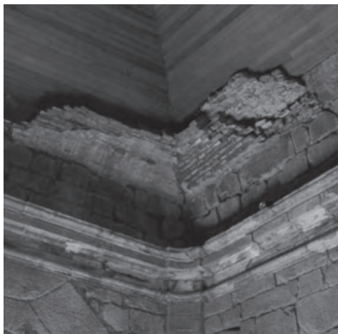
Figura 8: Vestigio de la bóveda construida con ladrillos y cal, 2005.
