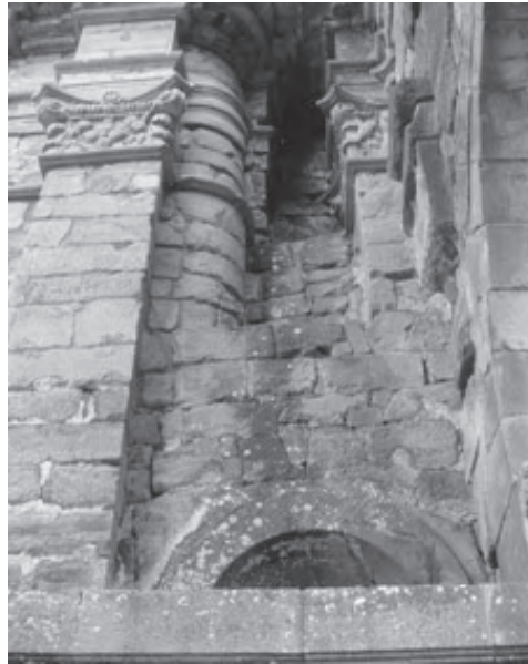
Figura 6: Junta de la torre con la iglesia mostrando la interferencia entre las dos construcciones, 2005.
