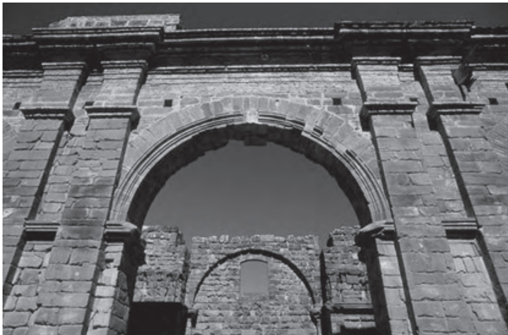
Figura 22: Arco estructuralmente recuperado, 1985 - 1986.
