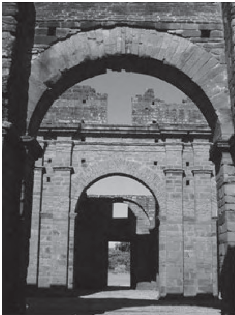
Figura 9: En primer plano se ve el arco original en piedra con la pared de ladrillos sobre él, en segundo el arco rehecho en ladrillos, 2005.
