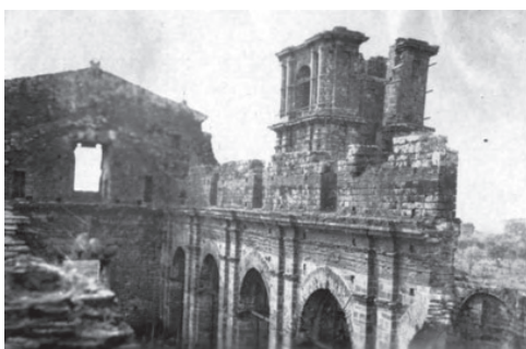
Figura 15: Vista interna de la nave central - arcada del lado de la epístola, después de la colocación de los rieles, 1927.
