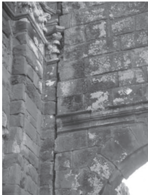
Figura 7: Junta que demuestra la falta de amarre del pórtico a la iglesia, 2005.
