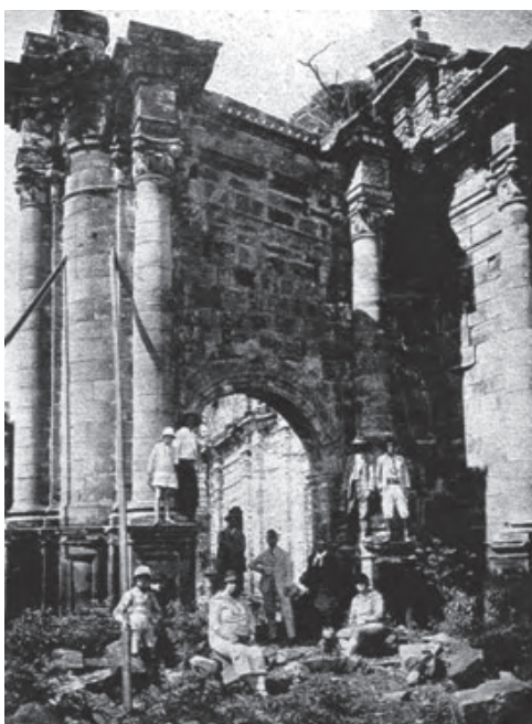
Figura 14: Pared lateral oeste del pórtico después de la estabilización, 1925.
