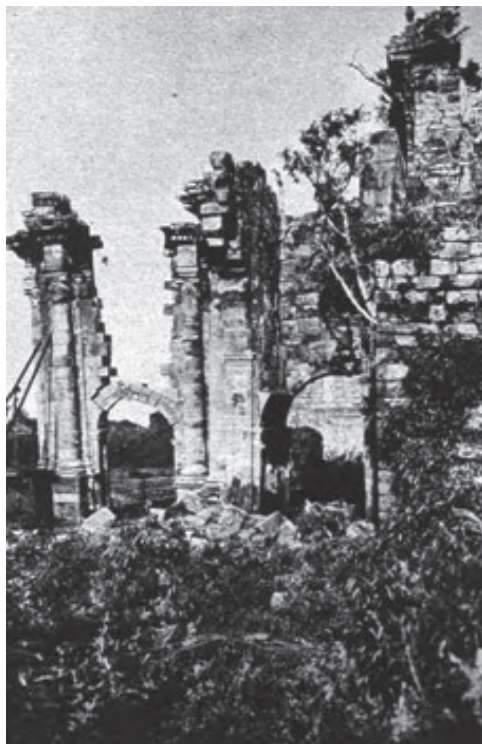
Figura 13: Pared del pórtico, lateral oeste, antes de la consolidación, 1925.
