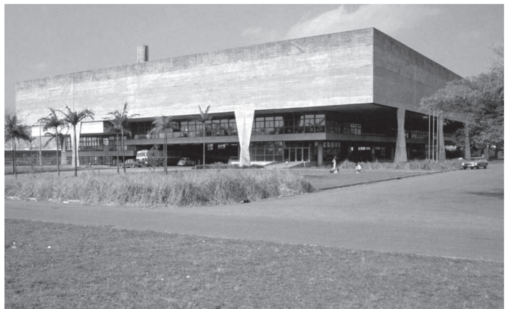
Figuras 6 y 7: Edificio de la Facultad de Arquitectura y Urbanismo, Universidad de São Paulo. João Batista Vilanova Artigas, (1962-1969). 1976.
