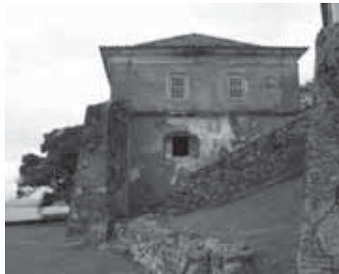
Figuras 22 y 23: Quartel da Tropa, en Santa Cruz de Anhatomirim, 2005. Restauración de un tramo de revoque y capeamentos de los contrafuertes. Estado de la pared antes y durante los trabajos de interven- ción que se están realizando.
