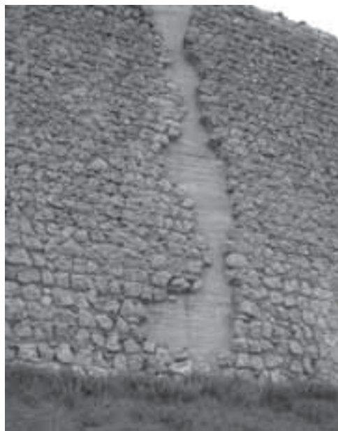
Figuras 16 a 19: Murallas de Atienza, España, 2005. Proyecto y obra coordinada por el IPHE. Trabajos de sustentación de tramos destruidos, desagregados o faltantes, utilizando piedras de la misma muralla, similares, o piedras artificiales y argamasas de cal, así como concreto con cal hidráulica y tierra de varios colores.
