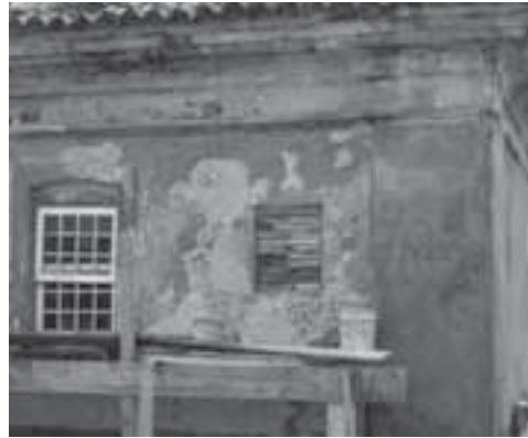
Figura 25: Aplicación de argamasa de acabado con arena tamizada. La argamasa fue aplicada con cuchara y compactada en la superficie, dando como resultado una superficie arenosa uniforme para distinguirla de las texturas del revoque antiguo y aumentar la superficie de evaporación, 2005.
