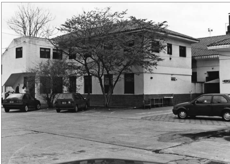
Figura 4. A la izquierda, el edificio en el que funcionaban los Consultorios Externos. A la derecha y lindante, la Morgue.
