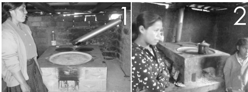
Imagen 1: estufa que muestra la deficiencia en el conducto galvanizado que debiera dirigir el humo hacia el exterior de la cocina.
